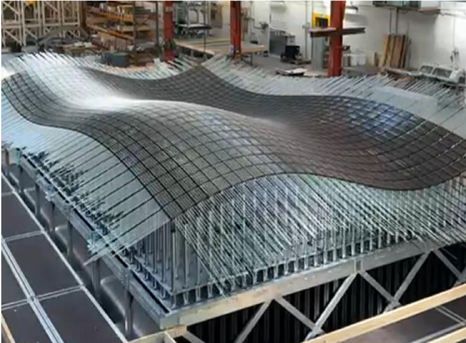
7x4m mould at Thyssenkrupp in Kiel
